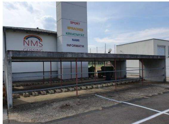
Sichere Abstellmöglichkeiten (Anlehnbügel) sollten an allen Zielpunkten vorhanden sein – Vorderradhalter wie am Bild unzureichend
