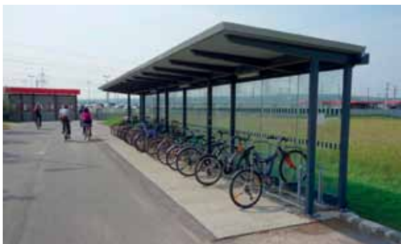
Abb. 10: Bike&Ride-Anlage Bahnhof Parndorf-Ort
