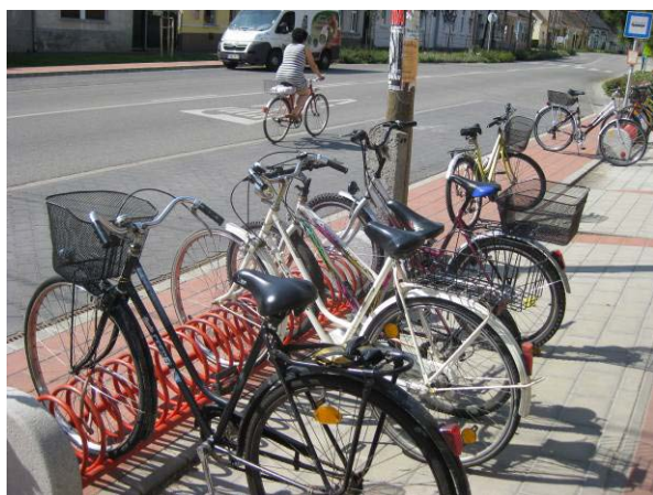
17. kép: Kerékpártároló időjárás-védelem nélkül és nincs lezárási lehetőség a váz részére (Magyarország)
