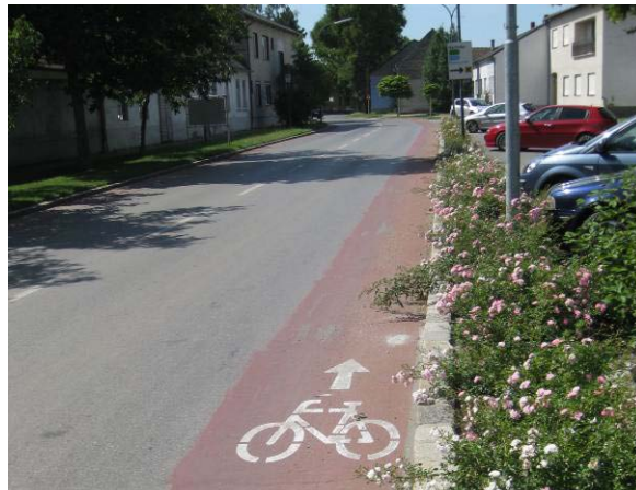
7. kép: Pirossal kiemelt útestest-rész kerékpárosok részére hiányos aszfaltjelzéssel (hiányos figyelmeztető-, vagy záróvonal) (Burgenland)
