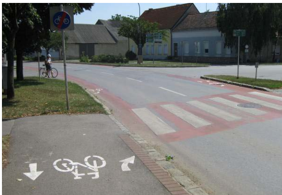
12. kép: Pirossal kiemelt zebra egy átkelőhelyen, a kerékpárút nyomvonalán, a kerékpárosok számára félreérthető piktogramokkal (Burgenland)
