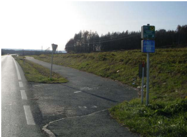
6. kép: Külön vezetett út kerékpárosoknak, jelzőtáblával való megfelelő jelzés nélkül (Burgenland)
