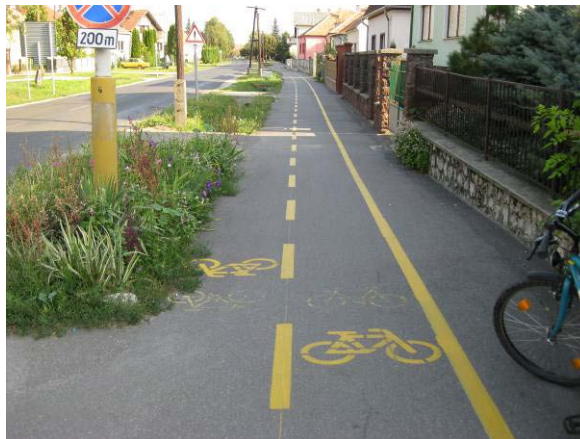
4. kép: Túl szűkre kijelölt kétirányú kerékpárút a járda mellett, fizikai elválasztás nélkül (Magyarország)
