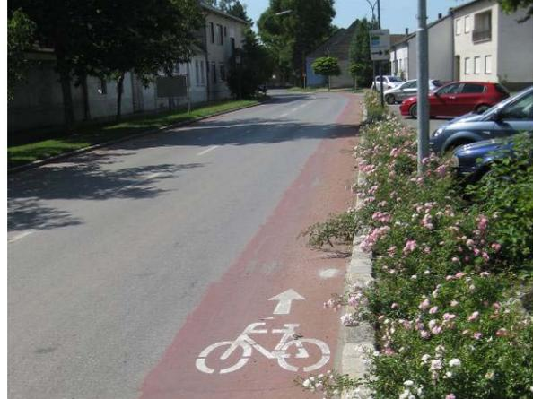
Abbildung 7: Rot hervorgehobener Teil der Fahrbahn für Radfahrer mit mangelhafter Kennzeichnung durch Bodenmarkierungen (fehlende Warn- oder Sperrlinie) (Burgenland)
