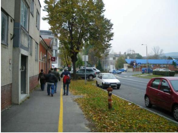
Abbildung 3: Zu schmal markierte Radfahranlage (Einrichtungsweg) unmittelbar neben Gehsteig ohne taktile wahrnehmbare Trennung vom Fußgängerbereich (Ungarn)
