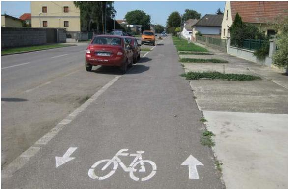
Abbildung 5: Zweirichtungsradweg unmittelbar neben Längsparkern ohne Schutzstreifen zum Schutz vor aufschlagenden Autotüren (Burgenland)
