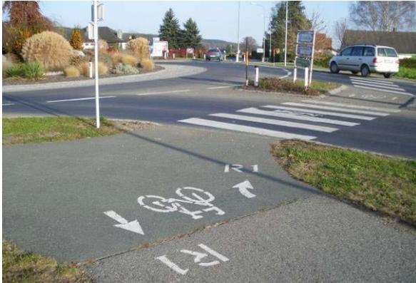
Abbildung 11: Schutzweg an einer Querungsstelle im Verlauf einer Radroute mit missverständlichen Piktogrammen für Radfahrer (Burgenland)
