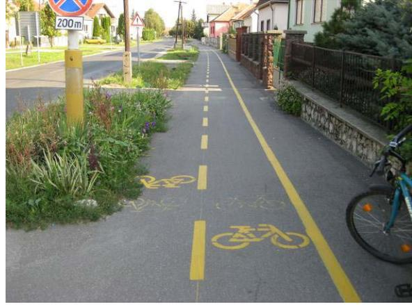
Abbildung 4: Zu schmal markierter Zweirichtungsradweg neben Gehsteig ohne taktile wahrnehmbare Trennung vom Fußgängerbereich (Ungarn)
