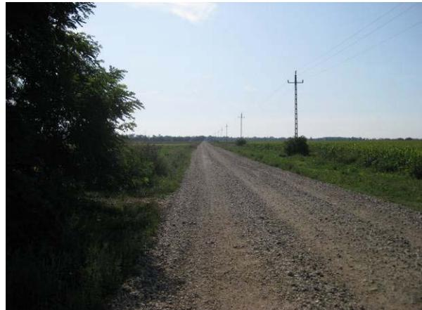
Abbildung 16: Abschnitt einer Radroute mit sehr grobem Schotter (Ungarn)
